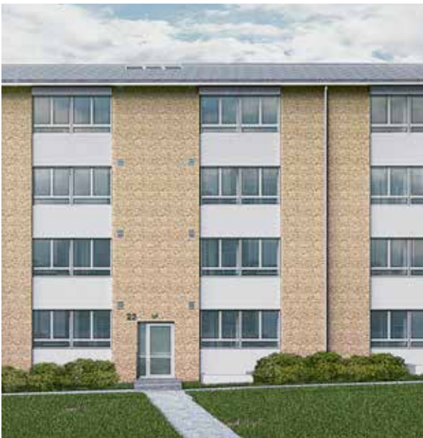
Indgangssiden med teglfacader.
