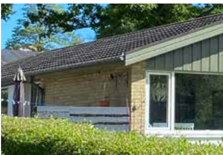
Ny efterisoleret skalmur af tegl.
