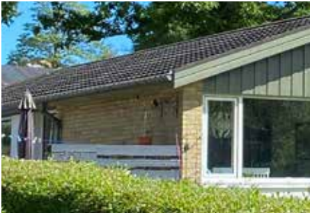
Ny efterisoleret skalmur af tegl.
