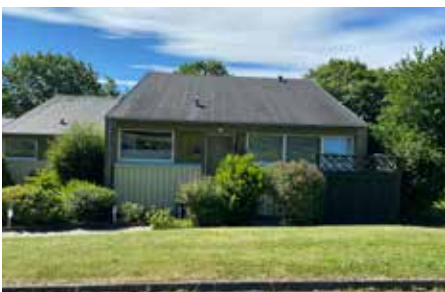
Udskiftning til vinduer med energiruder.
