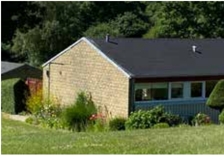
Ny efterisoleret skalmur af tegl.
