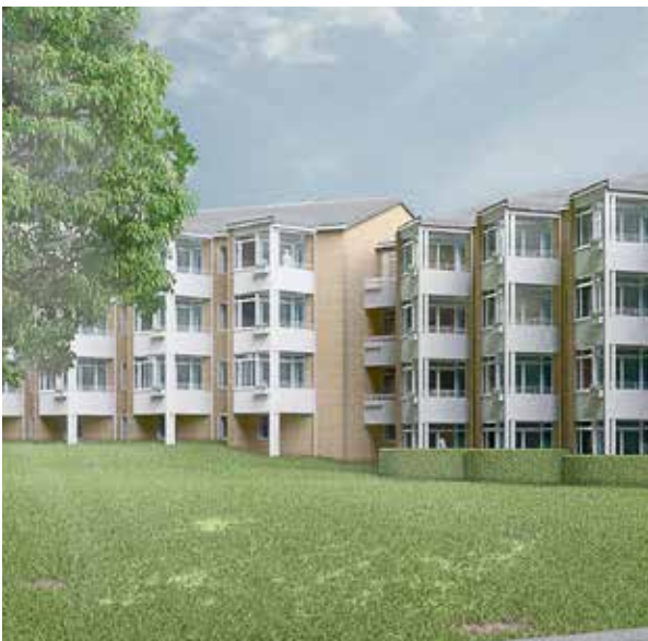
Nye teglfacader og nye hvide altaner mod haver.
