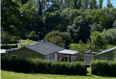
Taget udskiftes, og tagrummet isoleres.
