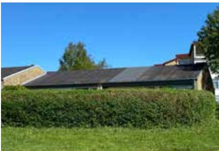
Taget udskiftes, og tagrummet isoleres.
