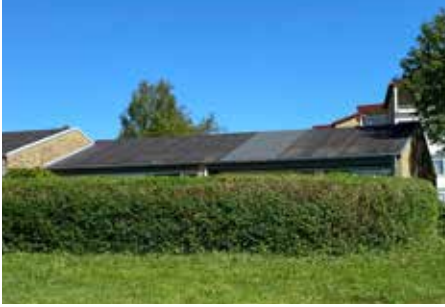
Taget udskiftes, og tagrummet isoleres.
