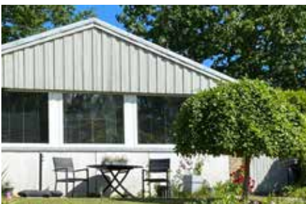
Udskiftning til vinduer med energiruder.
