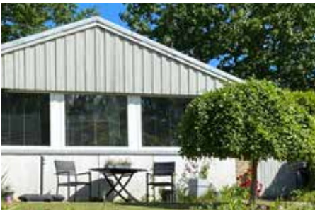
Udskiftning til vinduer med energiruder.
