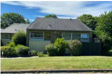
Udskiftning til vinduer med energiruder.
