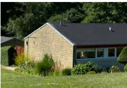
Ny efterisoleret skalmur af tegl.
