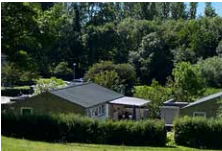
Taget udskiftes, og tagrummet isoleres.
